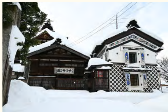
旧機那サフラン酒製造本舗・外観
